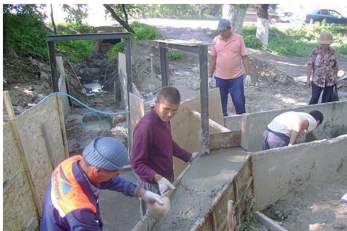
Строительство оросительного канала в селе Алга, Казахстан
